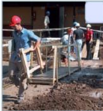
▶ Trabajadores y constructores reparando un colegio.
