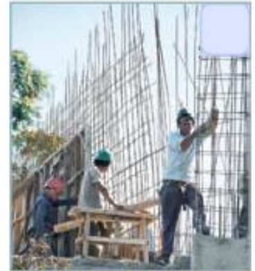
▶ Trabajadores construyendo un edificio en el centro de Santiago.
